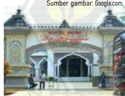
Penerapan Ukir khas Jepara sebagai identitas pada bangunan Masjid Agung Jepara
