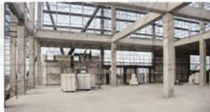
Struktur kolom balok menggunakan struktur grid kolom
