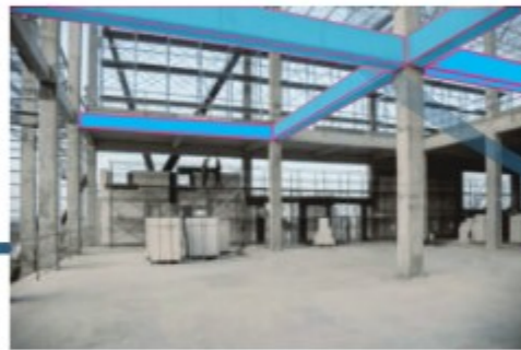
Struktur balok dihubungkan dengan struktur kolom melintang, juga berfungsi sebagai penyaluran pembebenan dan sebagai dudukan dari struktur atap
