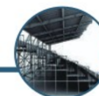
Rangka tempat duduk penonton merupakan material besi beton
