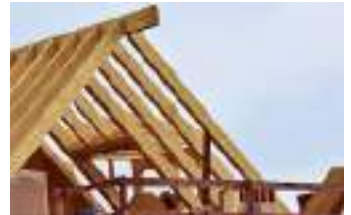
struktur rangka atap kayu
