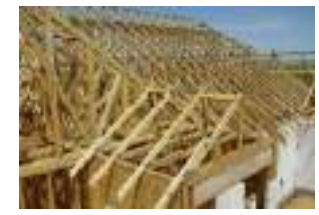
struktur rangka atap kayu
