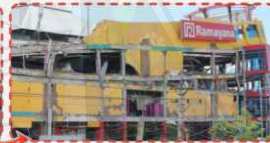
kerusakan akibat gempa
