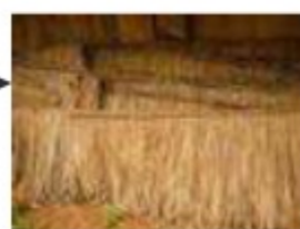
Penerapan material ilalang pada bagian atap sebagai penyejuk ruangan dan menambah kesan tropis pada bangunan
