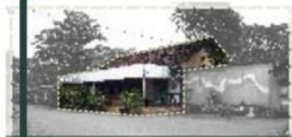
Bekas gedung operasional
