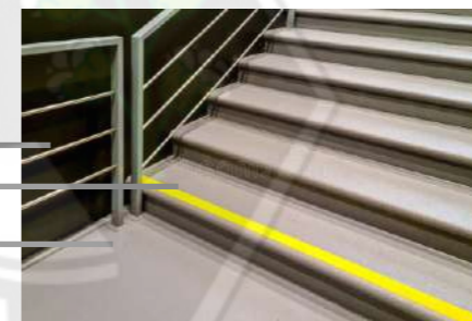
Handrail di sisi dinding & tangga
