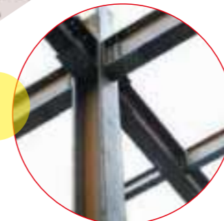
KOLOM BAJA TREATMENT material baja dengan finising Cat
