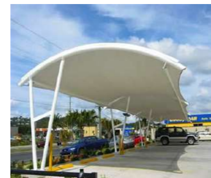
Struktur Membran sebagai peneduh untuk parkir pengelola, atau di taman
