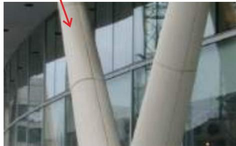
Menggunakan struktur kolom V dari material beton yang kuat dan tahan api serta mudah dibentuk
