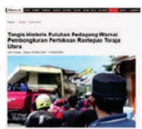
Proses pembongkaran pertokoan
