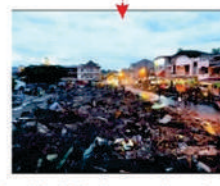
Setelah dilakukan pembongkaran
