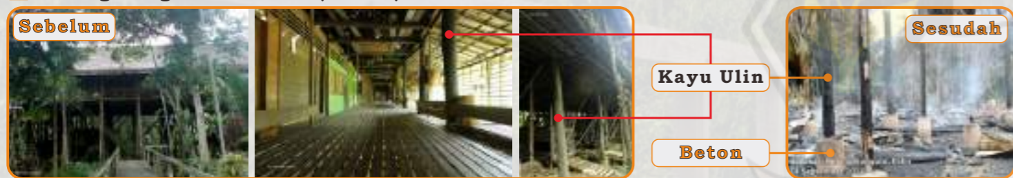
Memiliki Tinggi Kolom 9m ( Dahulu 13m ) & Kolom, Lantai & Atap Sirap dari Kayu Ulin
