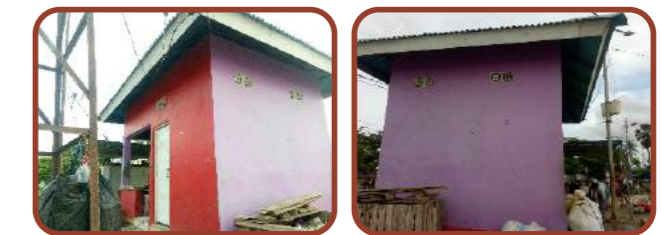
Pasar Oesapa memiliki 1 pos keamanan dan 1 toilet dalam satu bangunan
