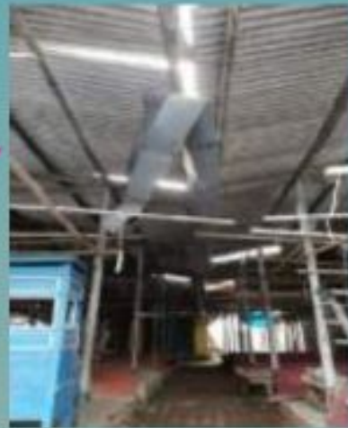
Peletakan masa bangunan terlalu berdekatan
