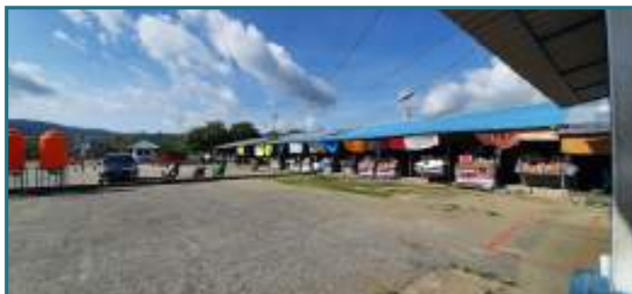
Tidak tersedia jalur pedestrian dari area parkir atau drop point ke bangunan terminal
