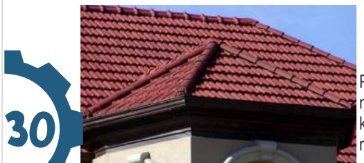
Pada Struktur atap memakai material genteng keramik karena mempertimbangkan resiko tiupan angin.
