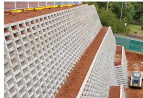
Dinding Kisi terbuat dari potongan potongan beton precast.
