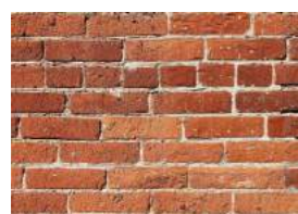
Pasangan batu bata
