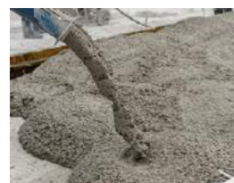
Beton untuk lantai
