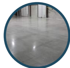
Lantai Panggung Lantai Beton
