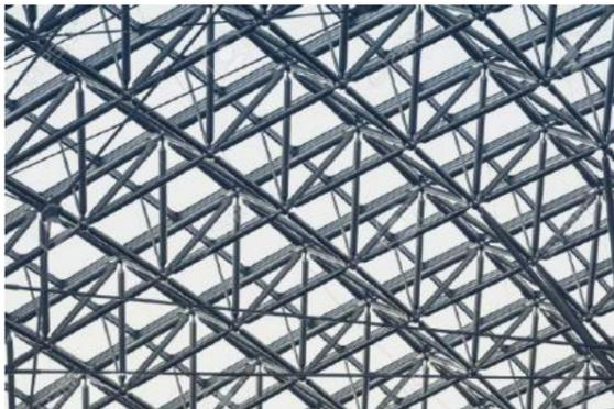
Struktur atap menggunakan struktur Space Frame dengan material baja. Penggunaan Space Frame lebih fleksible dan konstruksinya ringan.
