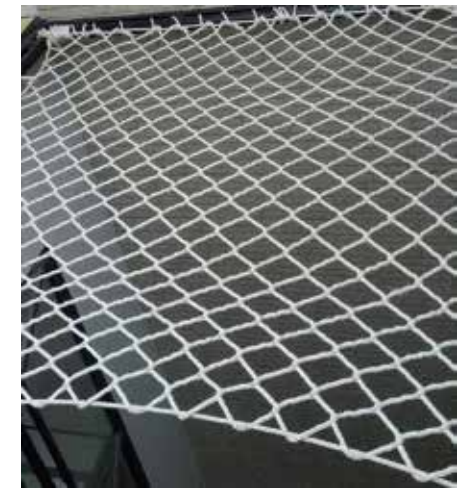
Lantai void yang dipasang jaring-jaring untuk bisa dipergunakan
