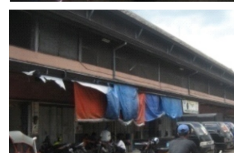
Menggunakan penghawaan alami dengan bukaan yang besar dan dilapisi oleh penutup kassa.
