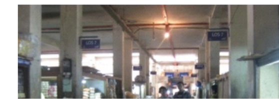
Menggunakan sistem grid beton bertulang jarak antar kolom ± 4-5 m.
