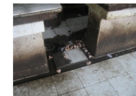
Piat lantai menggunakan material keramik Pada los daging dan ikan bidang lantai agak miring sehingga kotoran basah mudah masuk ke dalam saluran pembuangan di sepanjang los.
