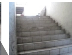
Tangga untuk Akses ke Lantai 2
