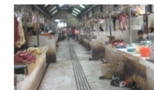
Piat lantai menggunakan material keramik Pada los daging dan ikan bidang lantai agak miring sehingga kotoran basah mudah masuk ke dalam saluran pembuangan di sepanjang los.
