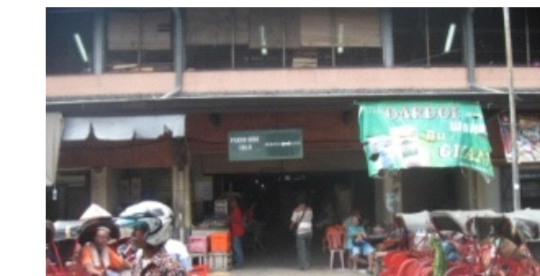
Menggunakan struktur rangka beton pada bagian tepi pasar yang berupa kios kemudian pada lantai 2 menerus berupa rangka baja.
