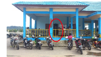
Toilet teletak di depan ruang tunggu penumpang
