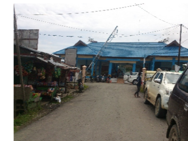
Jalan masuk pelabuhan penumpang
