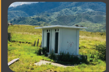
Gambar 7. Kondisi Toilet umum, januari 2019
