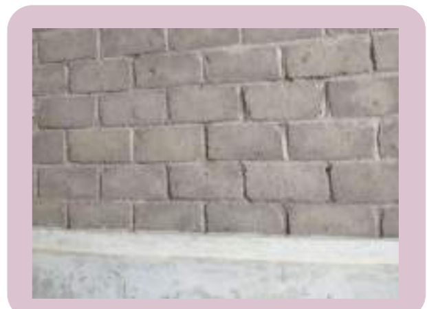
Pada sisi dinding lain menggunakan material batako ekspos membuat panas dari suhu diluar ruangan 'terperangkap' sehingga ruangan di dalamnya menjadi panas juga.
