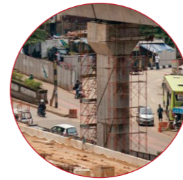
Kolom-kolom beton precast
