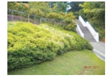
Di area ini akan di tanami vegetasi yang tidak terlalu tinggi agar tidak mengganggu facade
