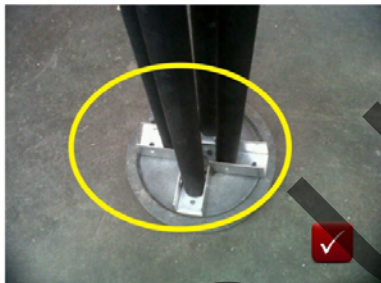
Penggantian material penyambung dari kayu menjadi plat besi, karena faktor kekuatan
