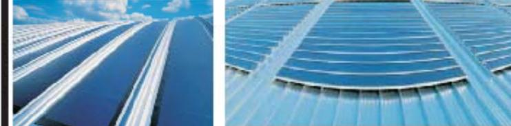
Penutup atap menggunakan atap Kalzip solar sistem dimana atap kalzip ini dapat mengikuti bentuk curved atau bentuk lengkung dengan sangat baik sehingga atap ini sangat baik untuk digunakan sebagai bahan penutup atap.
