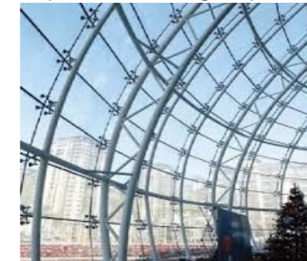
penggunaan material kaca untuk dinding yang di padukan dengan pemakian besi hollow.
