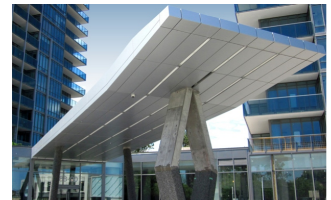
penggunaan aluminium komposit pada detail lobby dan area depan shopping center, digunakan sebagai sarana teduh antara lobby dengan area plaza.
