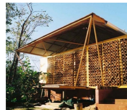
element bambu menjadi salah satu pilihan untuk dijadikan material bagi beberapa dinding dan ornament lainnya.
