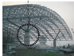
AREA YANG TIDAK MENGGUNAKAN STRUKTUR KOLOM BETON MENGGUNAKAN STRUKTUR KOLOM SILINDER
