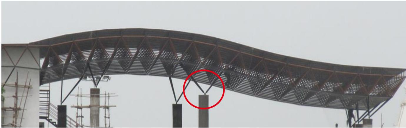
Struktur atap pada bangunan kandang hewan menggunakan struktur atap bentang lebar space frame. sistem struktur atap ini dipakai untuk mengeksplor bentuk atap dari konsep yang direncanakan.
